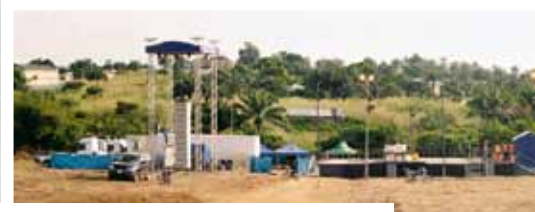
Wie immer wird das CfaN-Equipment auf einem großen, freien Feld aufgebaut.
